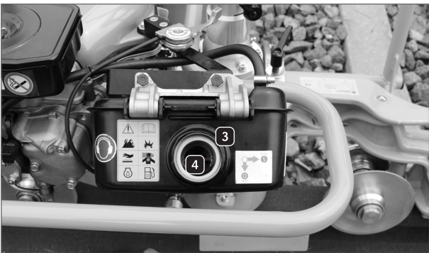
Abbildung 27: GP 4000 D – Diesel auffüllen 2
