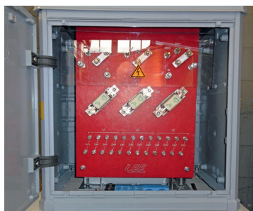
Skrzynka transformatorowa (do każdej zwrotnicy) Силовой трансформатор (для каждой стрелки)
