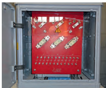
Transzformátor doboz (minden kitérőhöz) Power transformer (for each switch)
