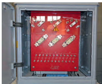
Boîtier de transformateur (pour chaque aiguillage) Transformador de potencia (para cada aguja)
