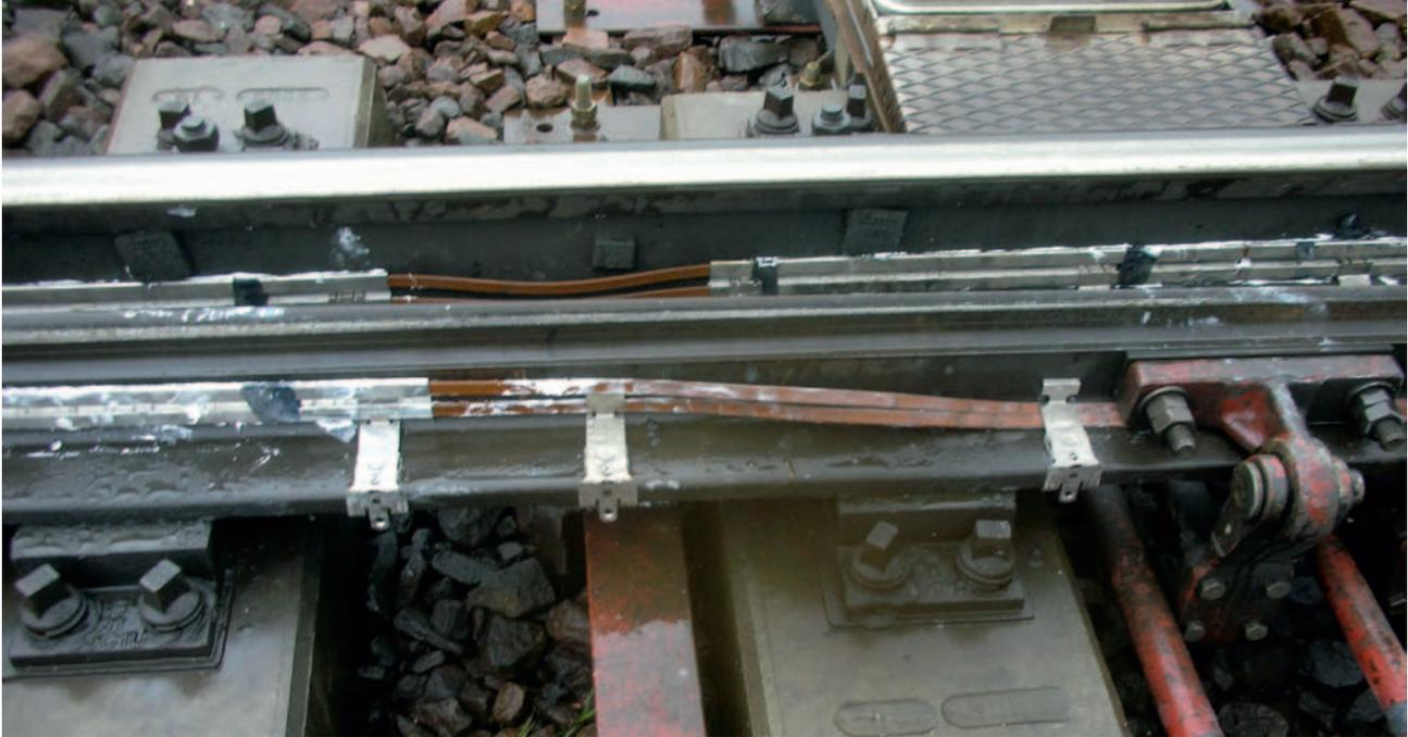
Kabelkanal (einzeln und doppelt) für selbstregulierendes Heizkabel, Länge je nach Weichenart.
